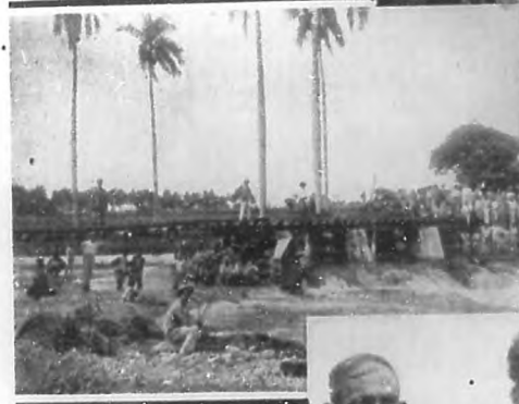
LA INUNDACION EN CALABAZAR DE SAGUA. —La vía del ferrocarril luego de haber barrido la avalancha de agua sus terraplenes de piedra y tierra, luce como un original puente colgante.
