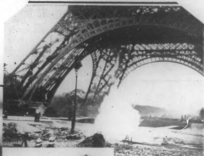
LA TORRE EIFFEL EN PELIGRO—Los ingenieros alemanes tratan de extinguir las llamas sumergidas que han surgido bajo la estructura de acero, a causa de una explosión de gas.
